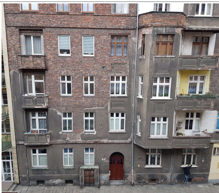
Elewacja frontowa od ul. Daszyńskiego-widok z naprzeciwka
