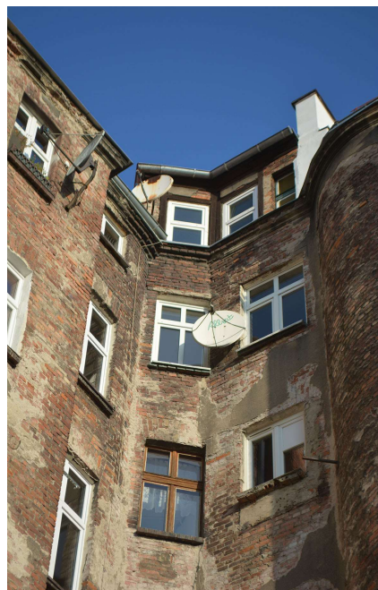
Elewacja podwórzowa-górne partie fasady
