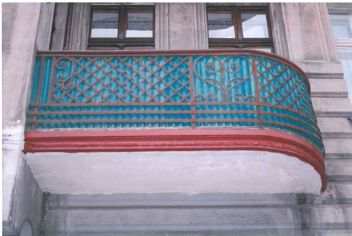
Fot. 15 Widok balkonu w elewacji frontowej od strony ulicy Daszyńskiego – widoczne uzupełnienia tynków płyty balkonowej oraz elementy stalowe konstrukcji zabezpieczone farbą antykorozyjną
