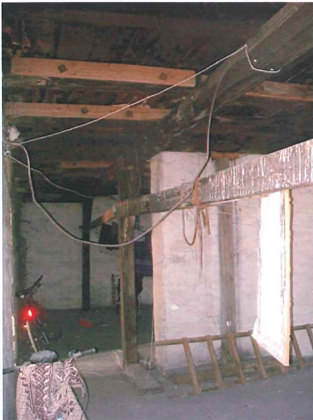
Fot. 32 i 33 Pomieszczenia strychowe na poziomie poddasza – widok wzmocnionych elementów więźby dachowej – elementy drewnianej więźby zaleca się zaimpregnować środkiem ognio i owadochronnymi
