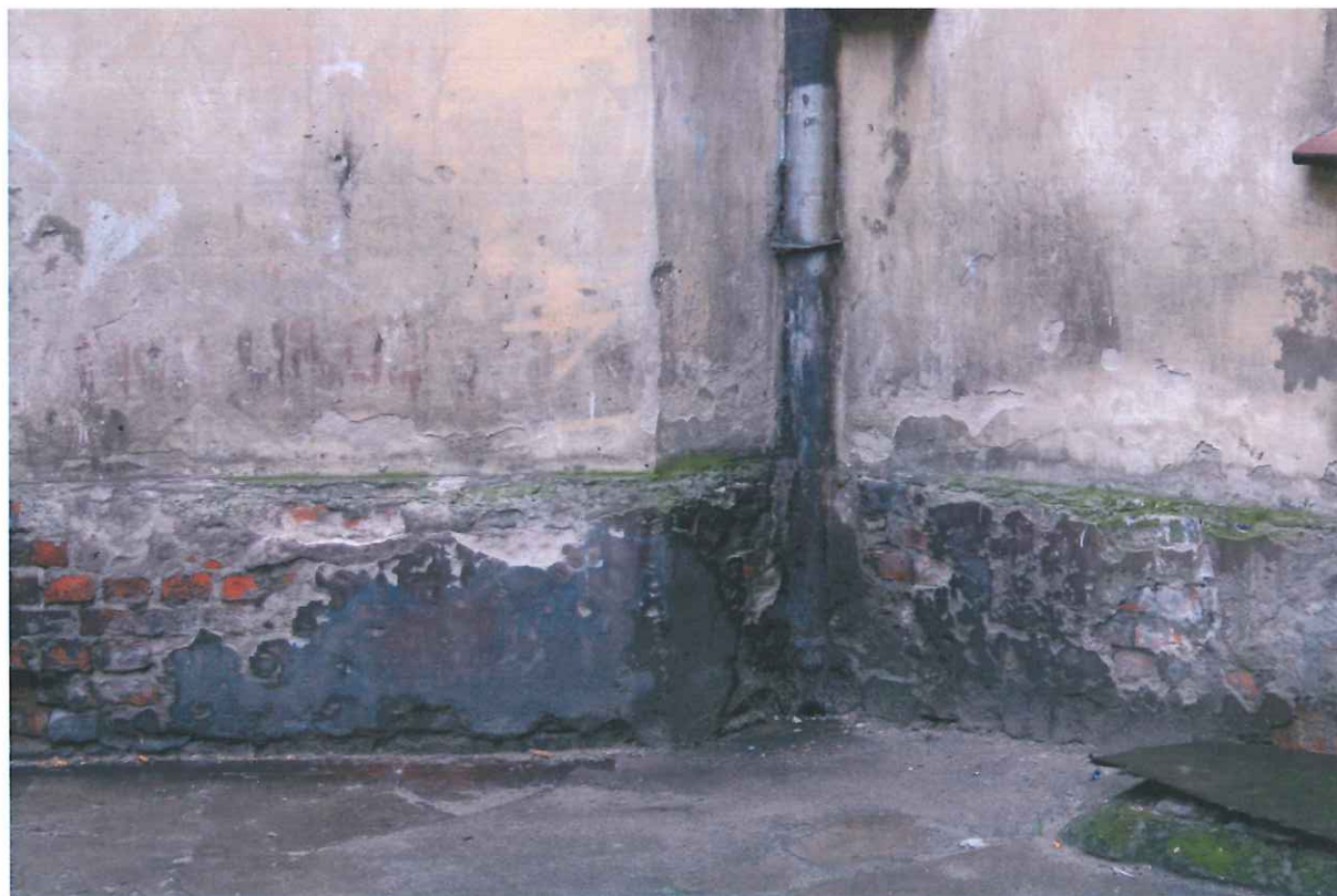
Fot. 10 Elewacja podwórzowa od strony ulicy Wyszyńskiego – widoczne zabrudzenia, ubytki tynków oraz zawilgocenia strefy cokolowej
