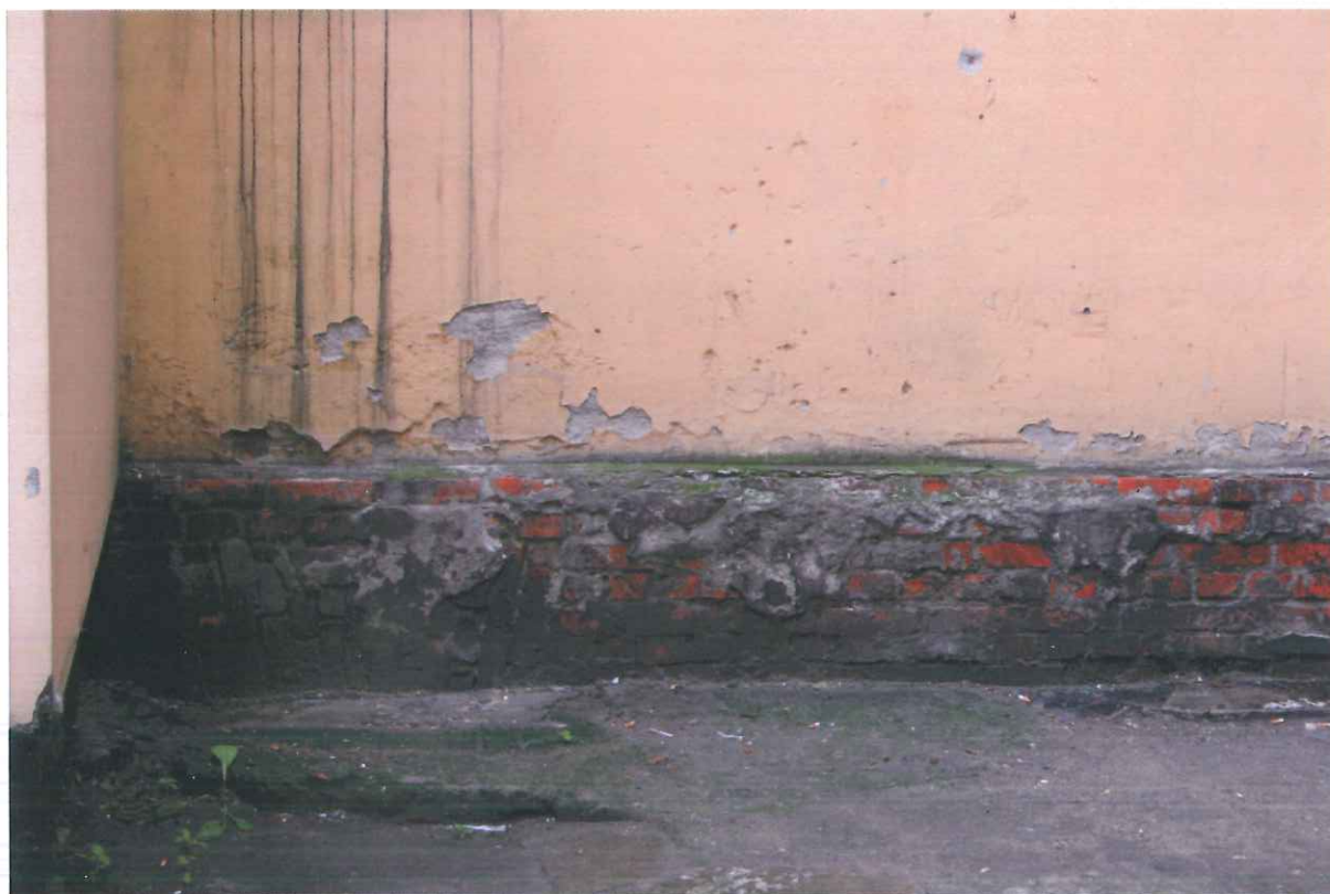
Fot. 11 Elewacja podwórzowa od strony ulicy Daszyńskiego – widoczne zabrudzenia, ubytki tynków oraz zawilgocenia strefy cokołowej
