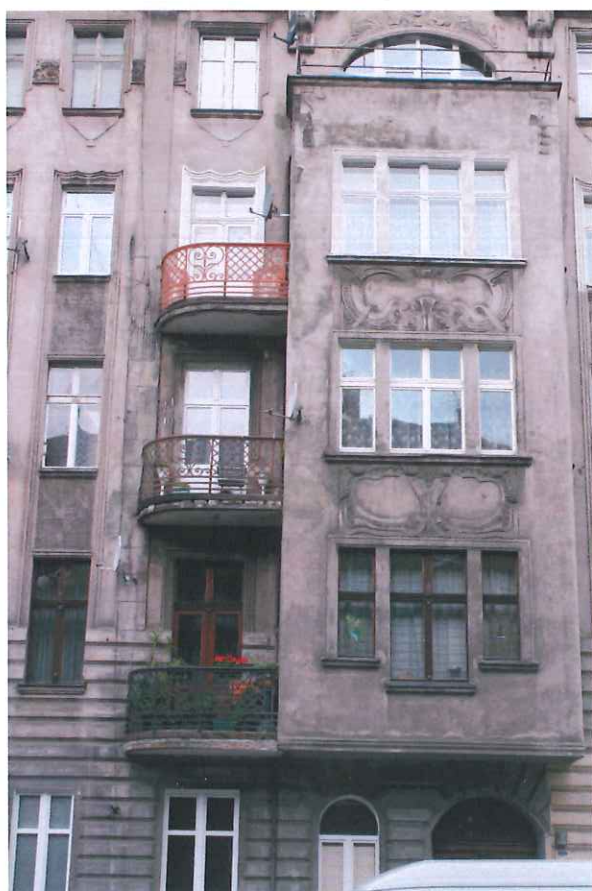
Fot. 1 Widok elewacji frontowej od strony ulicy Wyszyńskiego – widoczne zabrudzenia tynków i uszkodzenia balkonów
