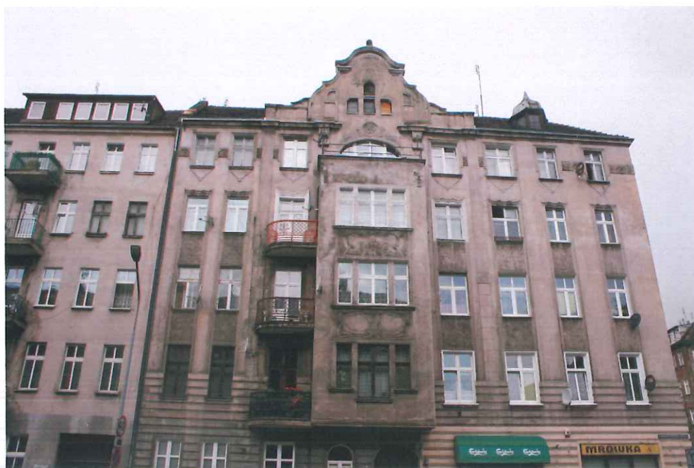
Fot. 1 Widok elewacji frontowej od strony ulicy Wyszyńskiego – widoczne zabrudzenia tynków i uszkodzenia balkonów
