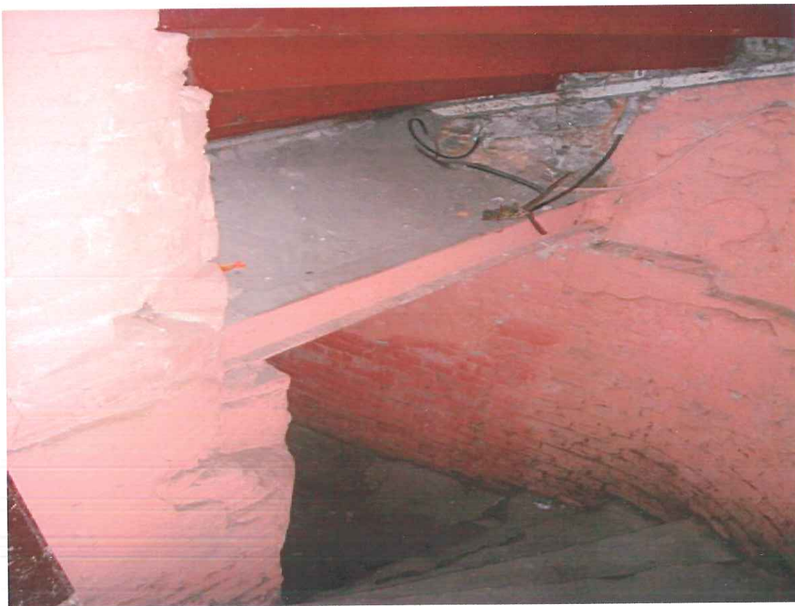
Fot. 18 Schody wejściowe do piwnicy – widoczne niewielkie pęknięcia ścian, drobne ubytki tynków oraz niewielkie zawilgocenia
