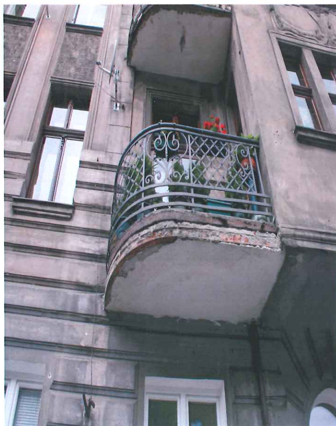
Fot. 2 Widok balkonów elewacji frontowej od strony ulicy Wyszyńskiego – widoczne zabrudzenia tynków i uszkodzenia balkonów przy wykuszu
