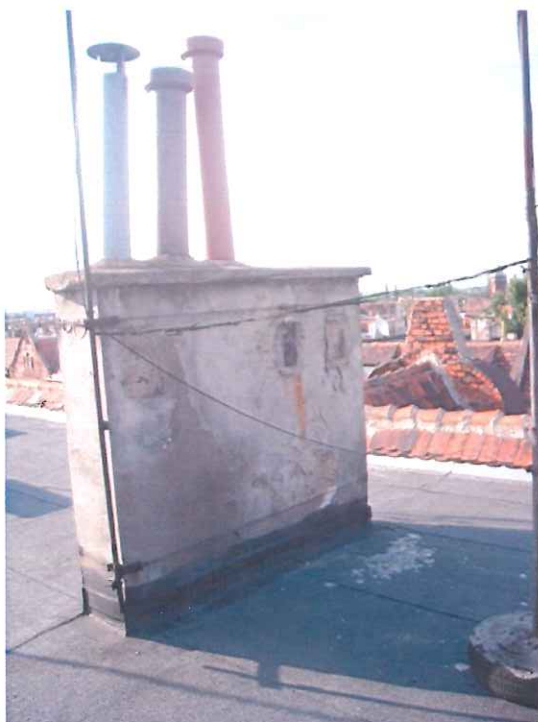
Fot. 28 Dach płaski budynku – widok spękanego komina powyżej połaci dachu; czapy kominowe nie zabezpieczone przeciwwilgociowa – pokrycie dachu papowe w dobrym stanie technicznym
