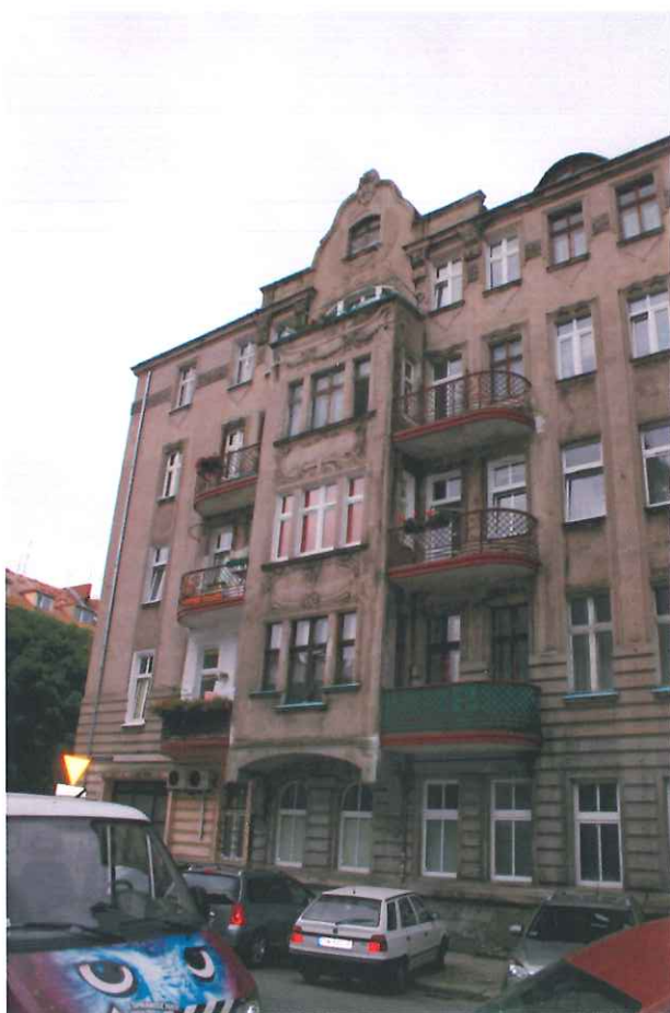
Fot. 12 i 13 Widok elewacji frontowej od strony ulicy Daszyńskiego – widoczne zabrudzenia tynków i uszkodzenia balkonów – zwietrzałe tynki zostały zbite, elementy stalowe konstrukcji zabezpieczone farbą antykorozyjną
