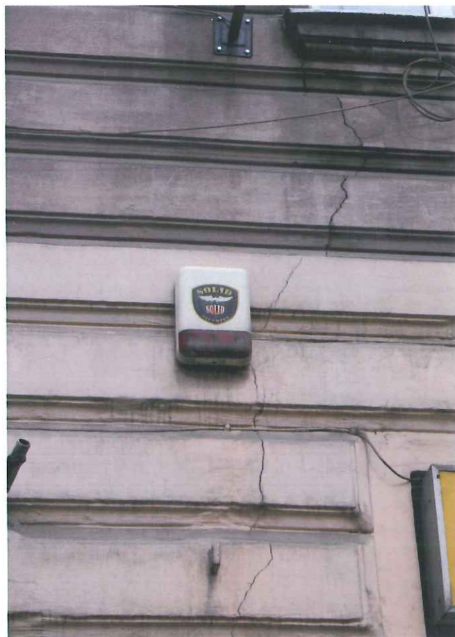
Fot. 5 i 6 Elewacja frontowa od strony ulicy Wyszyńskiego – widoczne zabrudzenia Tynków, zawilgocenia strefy cokolowej oraz spękania tynków
