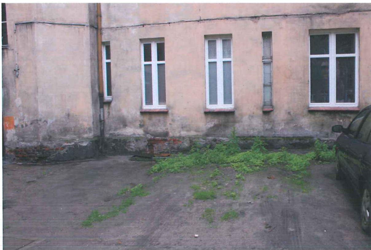
Fot. 9 Elewacja podwórzowa od strony ulicy Wyszyńskiego – widoczne zabrudzenia, ubytki tynków oraz zawilgocenia strefy cokolowej
