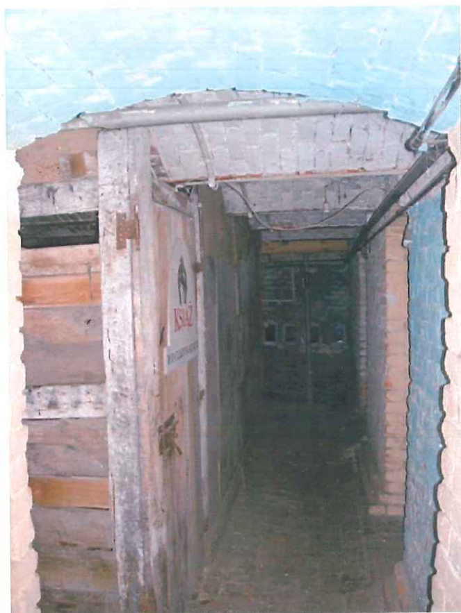
Fot. 19 Korytarze piwniczne – widoczne ubytki w posadzkach oraz ścianach
