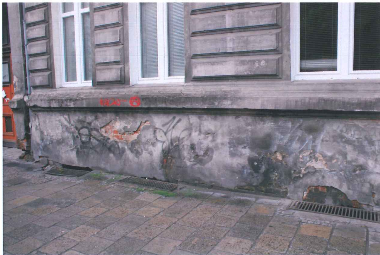
Fot. 4 Elewacja frontowa od strony ulicy Wyszyńskiego – widoczne zabrudzenia tynków oraz zawilgocenia strefy cokolowej
