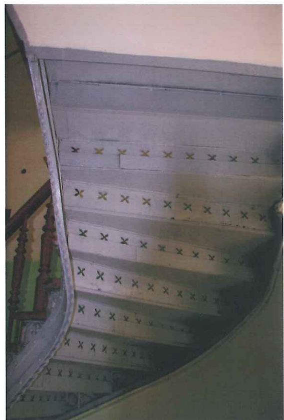
Fot. 27 Klatka schodowa – schody o konstrukcji stalowej – widoczne miejsca napraw
