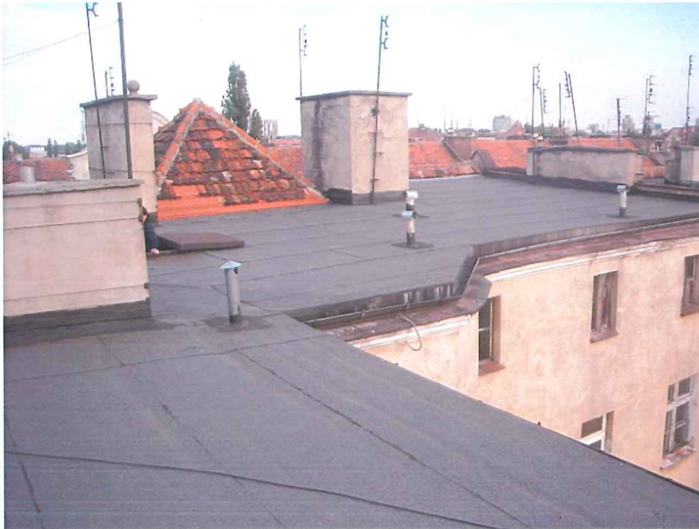
Fot. 31 Dach płaski budynku – rynny i obróbki blacharskie gzymsów podrynnowych i ogniomurów skorodowane, rynny miejscowo (na stykach) nieszczelne
