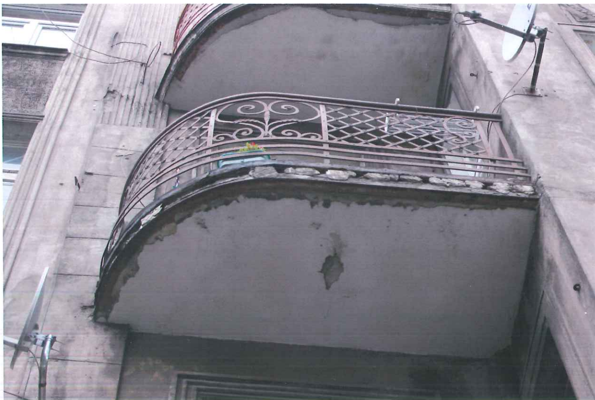
Fot. 3 Widok balkonów elewacji frontowej od strony ulicy Wyszyńskiego – widoczne zabrudzenia tynków i ogniska korozji na belkach stalowych i obróbkach blacharskich zewnętrznej krawędzi balkonu oraz ubytki tynków i zawilgocenia płyty nośnej
