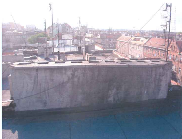
Fot. 29 i 30 Dach płaski budynku – widok spękanych kominów powyżej połaci dachu; czapy kominowe nie zabezpieczone przeciwwilgociowa
