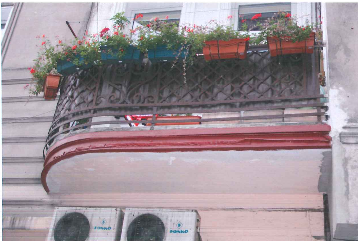
Fot. 14 Widok balkonu w elewacji frontowej od strony ulicy Daszyńskiego – widoczne uzupełnienia tynków płyty balkonowej oraz elementy stalowe konstrukcji zabezpieczone farbą antykorozyjną
