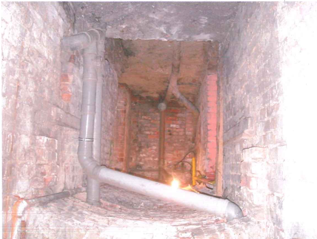
Fot. 21 Korytarze piwniczne – widoczne ubytki w posadzkach, ścianach oraz stropach – widoczne chaotyczne rozmieszczenie pionów i poziomów w kanalizacji sanitarniej
