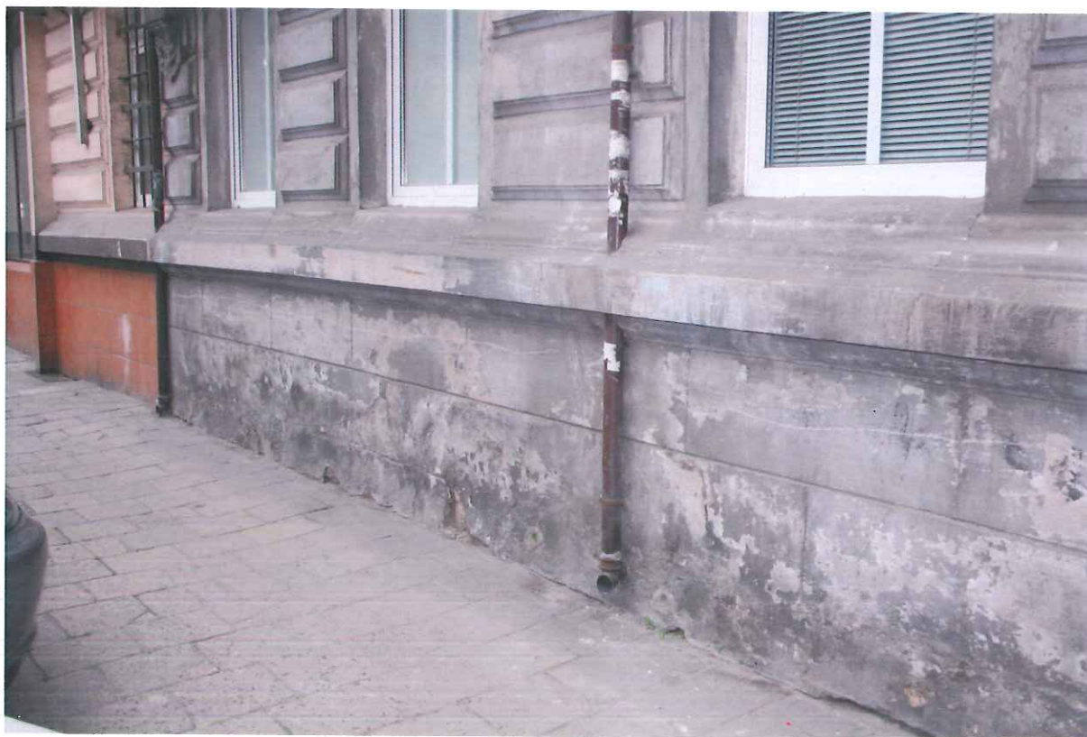
Fot. 16 Elewacja frontowa od strony ulicy Daszyńskiego – widoczne zabrudzenia, drobne ubytki tynków oraz zawilgocenia strefy cokolowej
