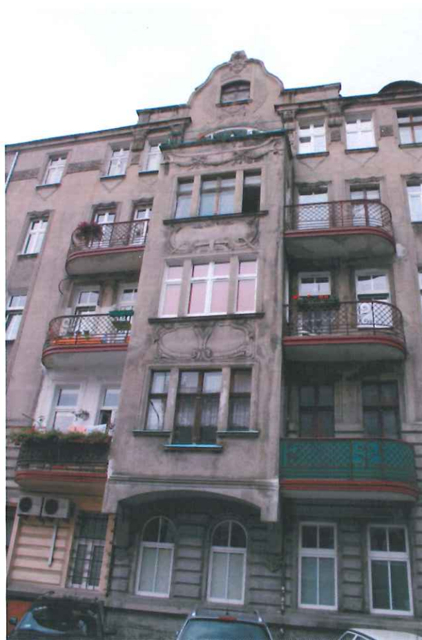
Fot. 12 i 13 Widok elewacji frontowej od strony ulicy Daszyńskiego – widoczne zabrudzenia tynków i uszkodzenia balkonów – zwietrzałe tynki zostały zbite, elementy stalowe konstrukcji zabezpieczone farbą antykorozyjną
