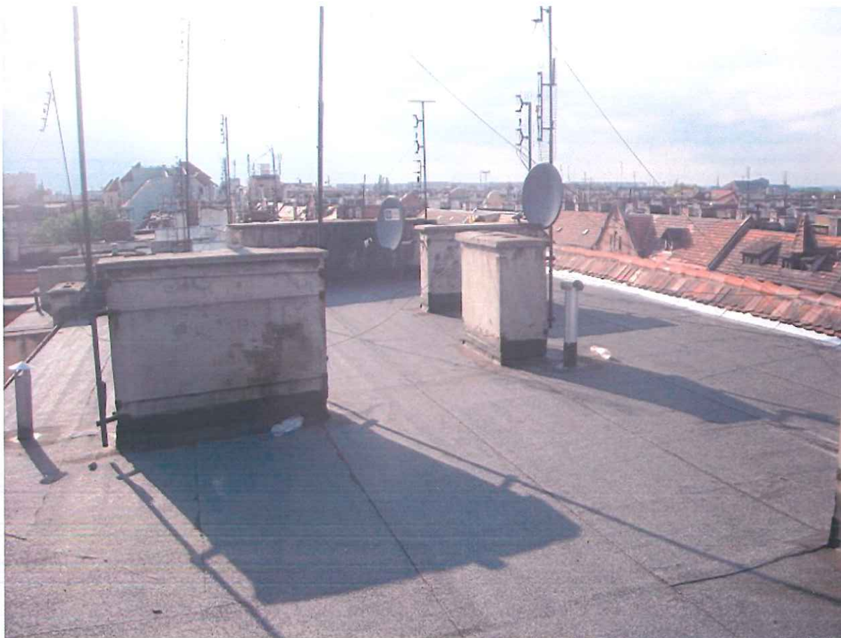
Fot. 28 Dach płaski budynku – widok spękanego komina powyżej połaci dachu; czapy kominowe nie zabezpieczone przeciwwilgociowa – pokrycie dachu papowe w dobrym stanie technicznym
