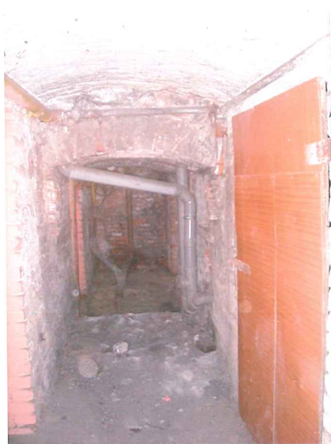
Fot. 19 Korytarze piwniczne – widoczne ubytki w posadzkach oraz ścianach
