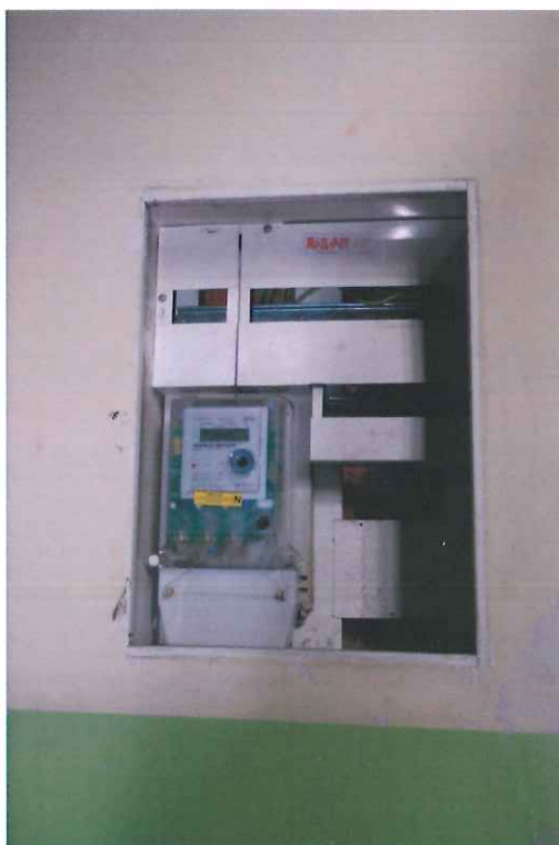
Fot. 23 Korytarz klatki schodowej – wyrwane drzwiczki szafki energetycznej
