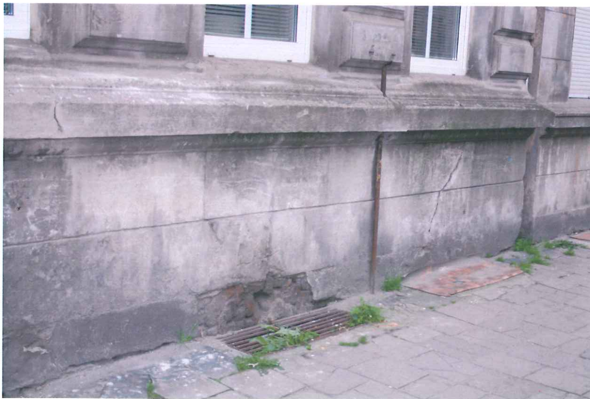
Fot. 17 Elewacja frontowa od strony ulicy Daszyńskiego – widoczne zabrudzenia, drobne ubytki tynków oraz zawilgocenia strefy cokolowej
