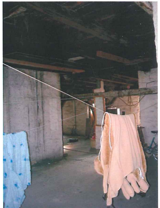
Fot. 32 i 33 Pomieszczenia strychowe na poziomie poddasza – widok wzmocnionych elementów więźby dachowej – elementy drewnianej więźby zaleca się zaimpregnować środkiem ognio i owadochronnymi
