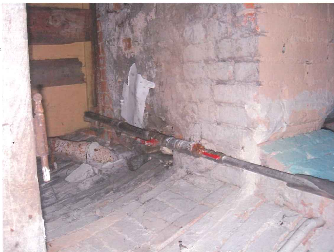
Fot. 20 Korytarze piwniczne – widoczne ubytki w ścianach oraz stropach – nieszczelność instalacji kanalizacyjnej oraz wodnej
