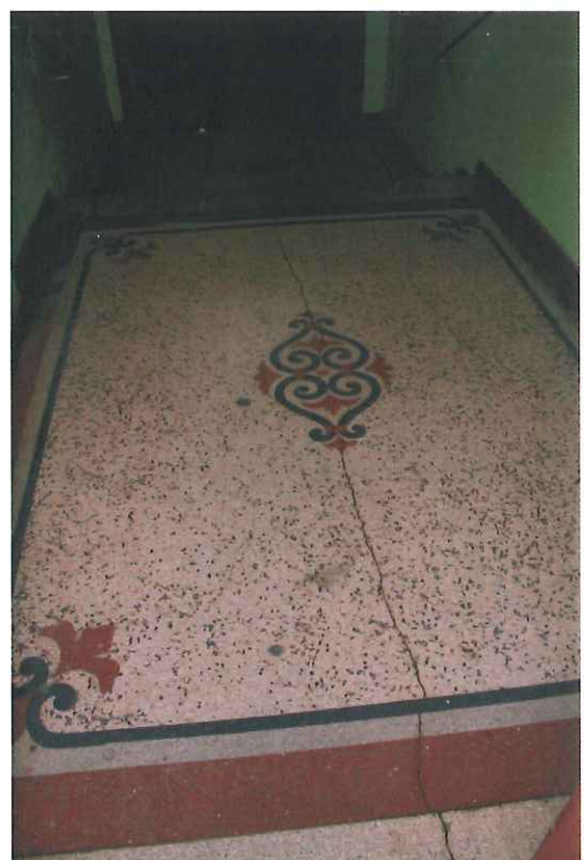
Fot. 24 Hol wejściowy – widoczne spękanie posadzki
