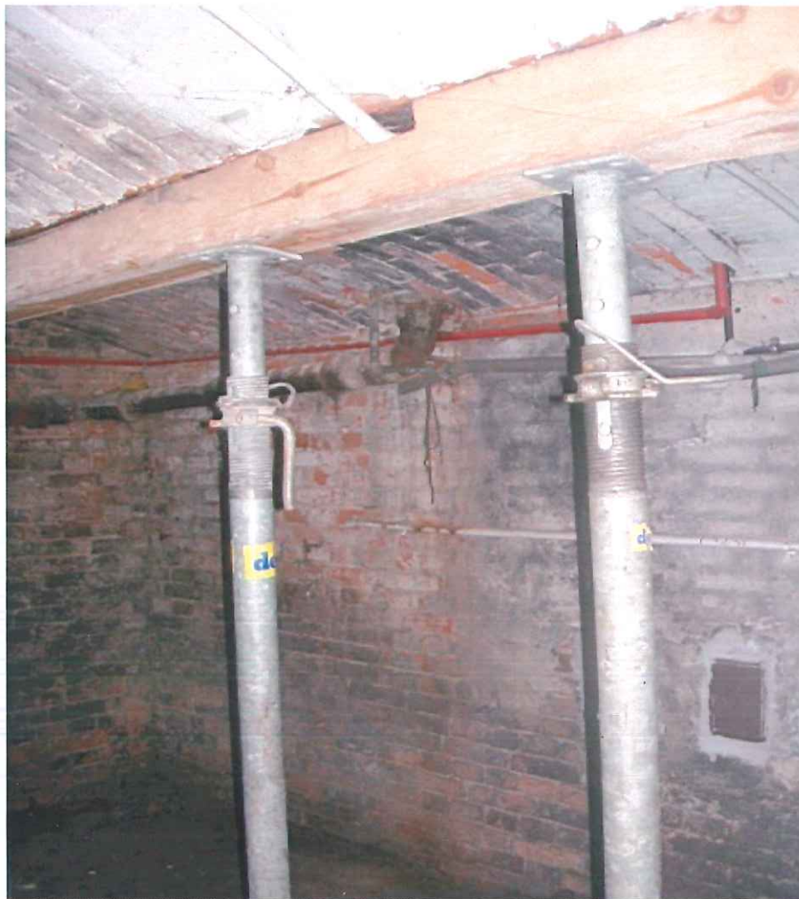
Fot. 22 Korytarz piwniczny – widoczny fragment podstemplowanego stropu odcinkowego – sklepienie ceglane stropu z lokalnymi ubytkami cegieł i spoin
