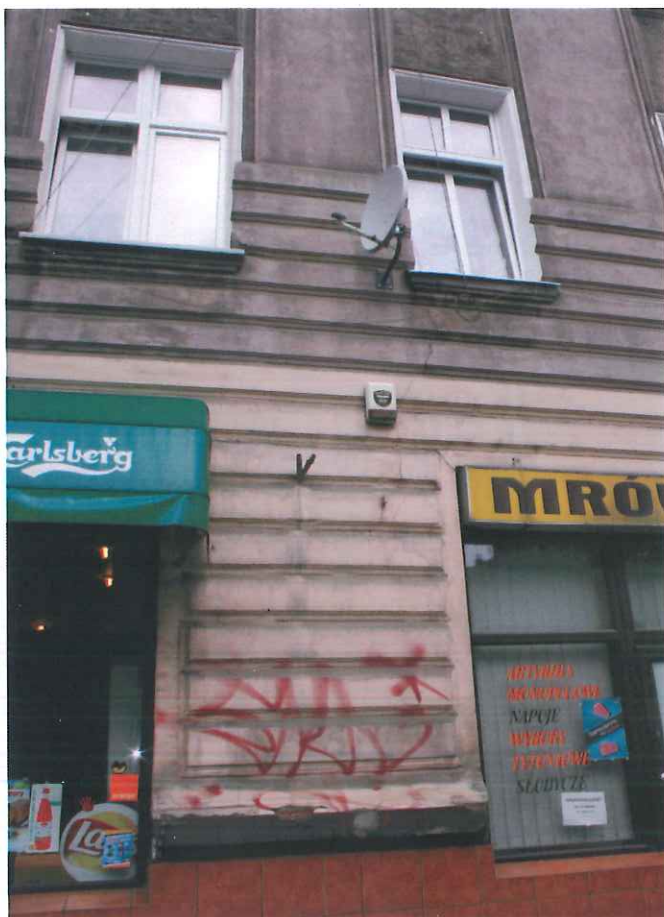
Fot. 5 i 6 Elewacja frontowa od strony ulicy Wyszyńskiego – widoczne zabrudzenia Tynków, zawilgocenia strefy cokolowej oraz spękania tynków
