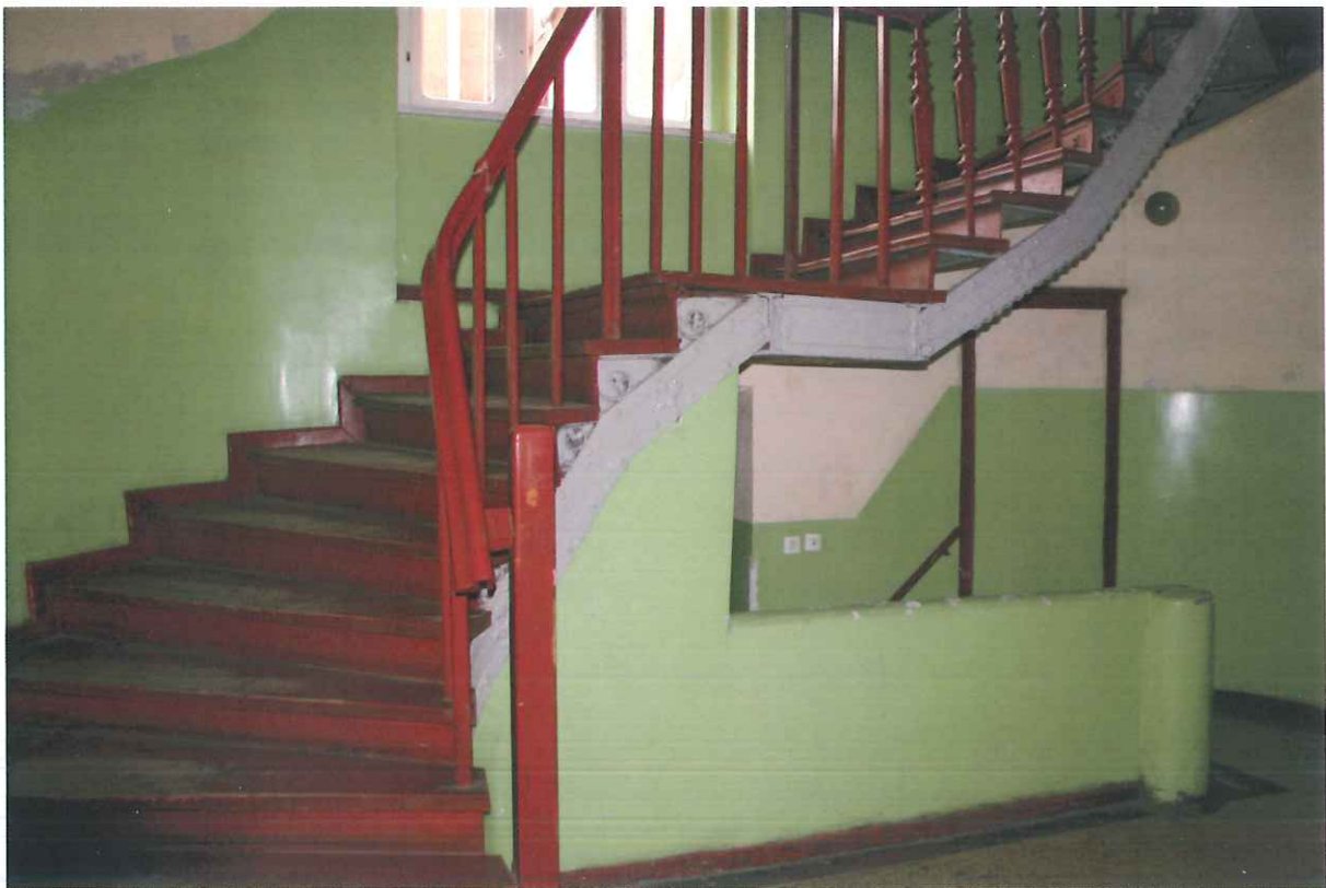
Fot. 25 Klatka schodowa odnowiona – widoczny pierwszy bieg w dobrym stanie elementy drewniane oraz stalowe
