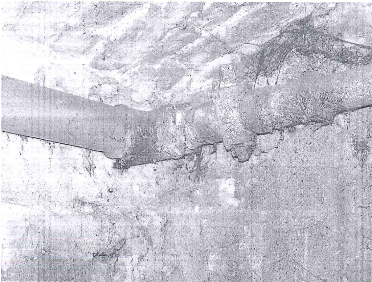
Fot. 3 i 4 Widok poziomów instalacji gazowej w piwnicy – rura czarna \varnothing 75 mm- widoczne zardzewienia rur gazowych
