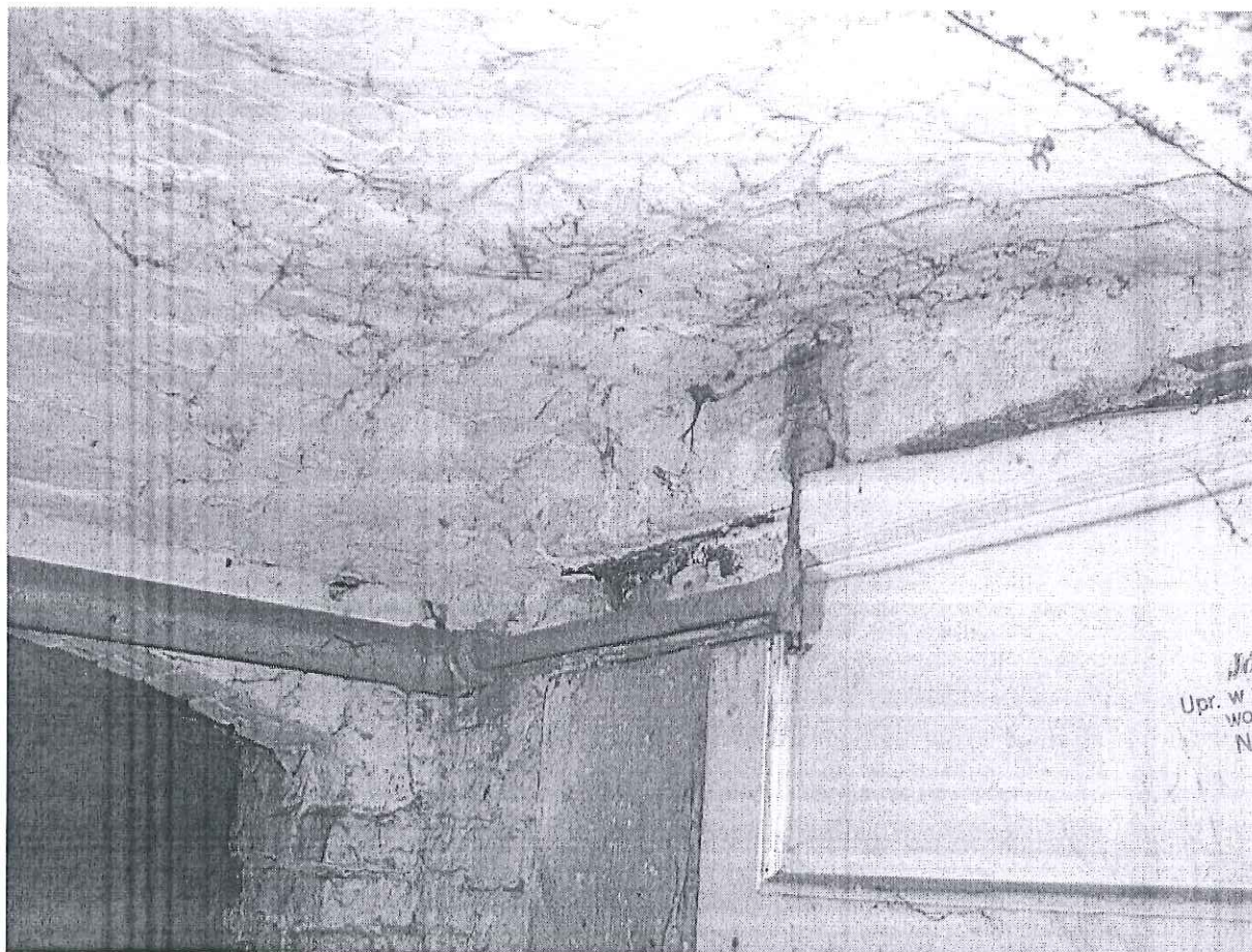
Fot. 3 i 4 Widok poziomów instalacji gazowej w piwnicy – rura czarna \varnothing 75 mm- widoczne zardzewienia rur gazowych
