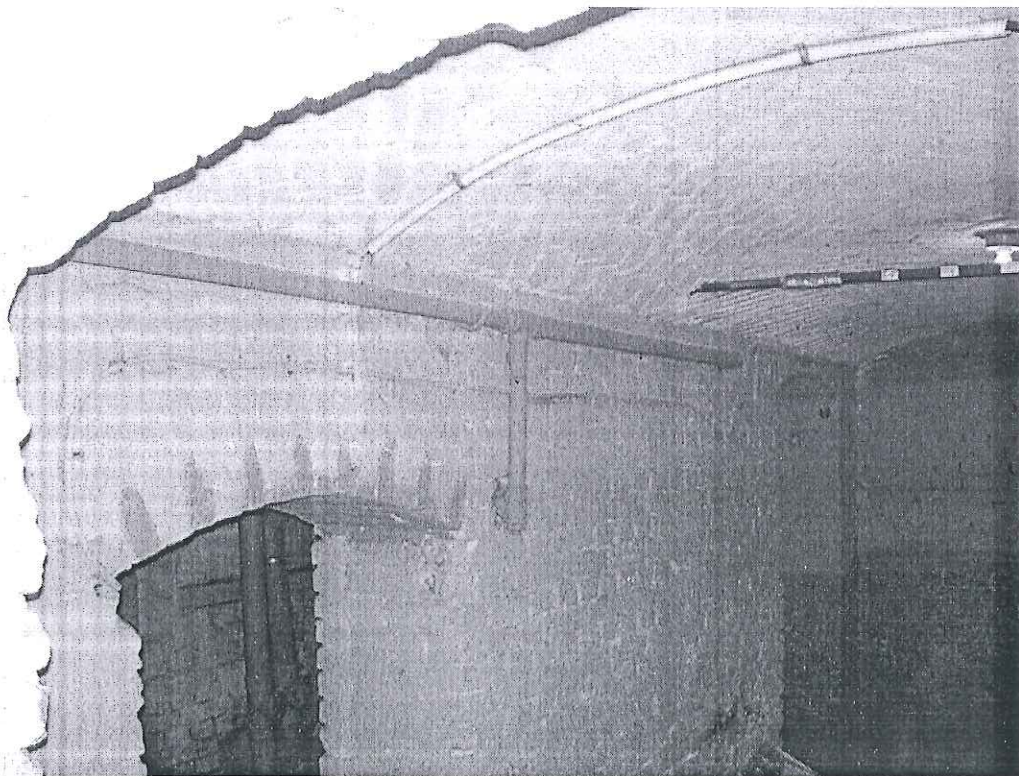
Fot. 10 Widok poziomu instalacji gazowej z przejściem w pion w piwnicy – rura czarna \varnothing 32 mm – widoczny brak tulei ochronnych oraz nieodpowiednio pomalowane rury
