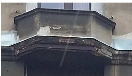
Balkon III piętra elewacji półn-wsch.
