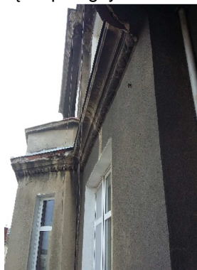
Gzyms podokapowy pod oknami III piętra, pokryty blachą ocynkowaną
