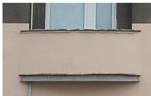
Balkon wysokiego parteru
