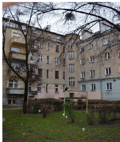
widok elewacji podwórzowej
