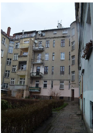
Widok elewacji podwórzowej
