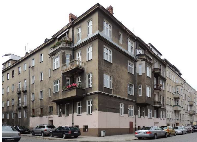
widok elewacji frontowej
