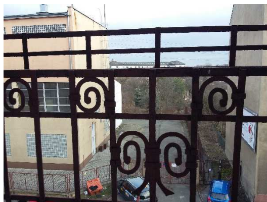
balustrada ażurowa balkonu II p.
