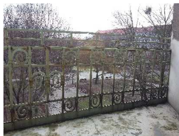
Balustrada ażurowa balkonu II p.
