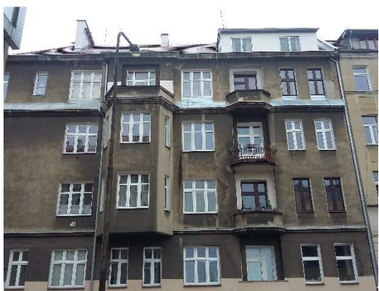
Widok wykusza, tarasu nad wykuszem i balkonów
