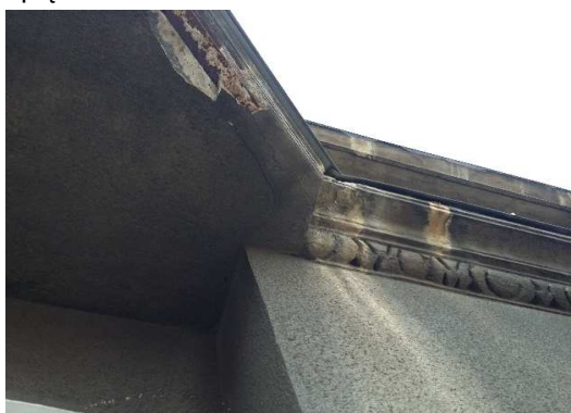
Gzyms podokapowy pod oknami III piętra, pokryty blachą ocynkowaną
