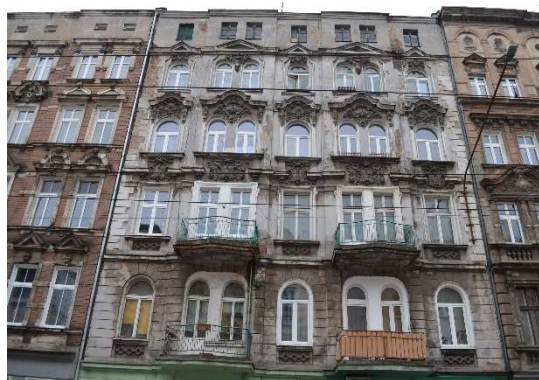
widok górnych partii elewacji
