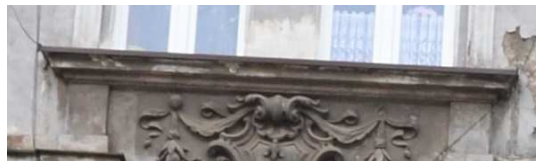
gzyms podokienny okna III piętra
