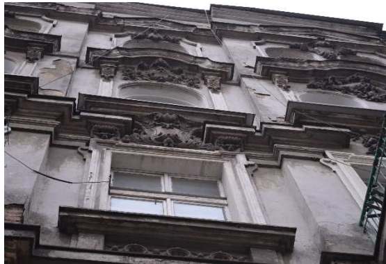
gzymsy i zdobienia obramienia okien górnych kondygnacji
