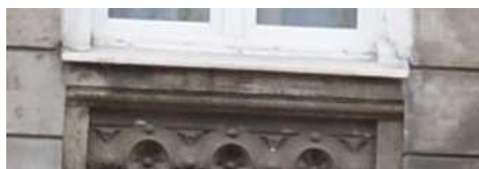
gzyms podokienny okna I piętra
