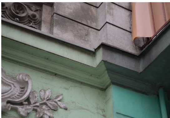
gzyms na wysokości stropu nad parterem
