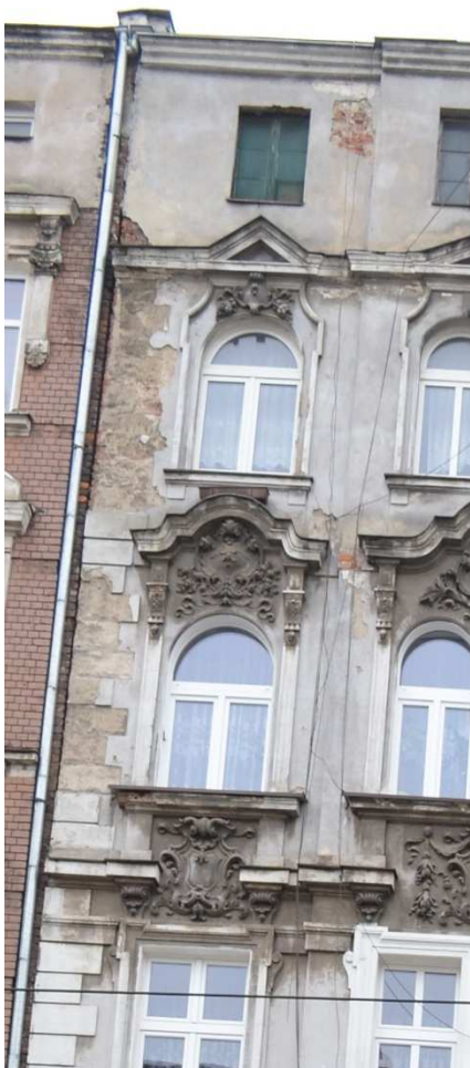
Ubytki tynków spowodowane nieuszczelnnością rury spustowej ubytki gzymsów i tynków górnej partii elewacji frontowej
