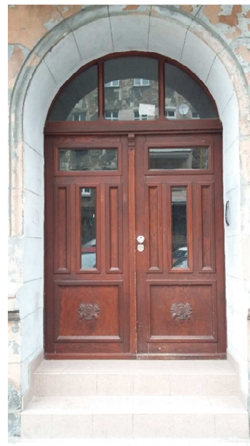
drzwi wejściowe do budynku
