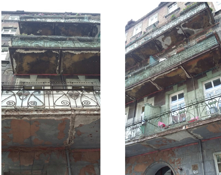
spody balkonów widziane z poziomu chodnika
