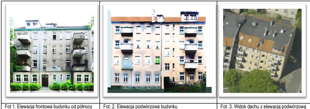
Fot 1. Elewacja frontowa budynku od północy
