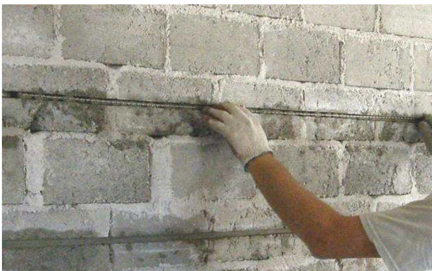
Rys. 5. Osadzenie pręta w bruzdzie muru (rysunek poglądowy) [6-15].
