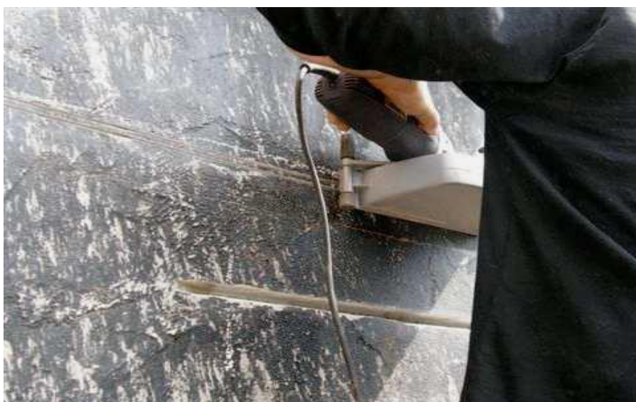
Rys. 3. Sposób wykonywania bruzd w uszkodzonej ścianie (rysunek poglądowy) [6-15].
