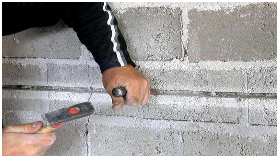
Rys. 4. Czyszczenie i wyrównanie bruzdy (rysunek poglądowy) [6-15].
